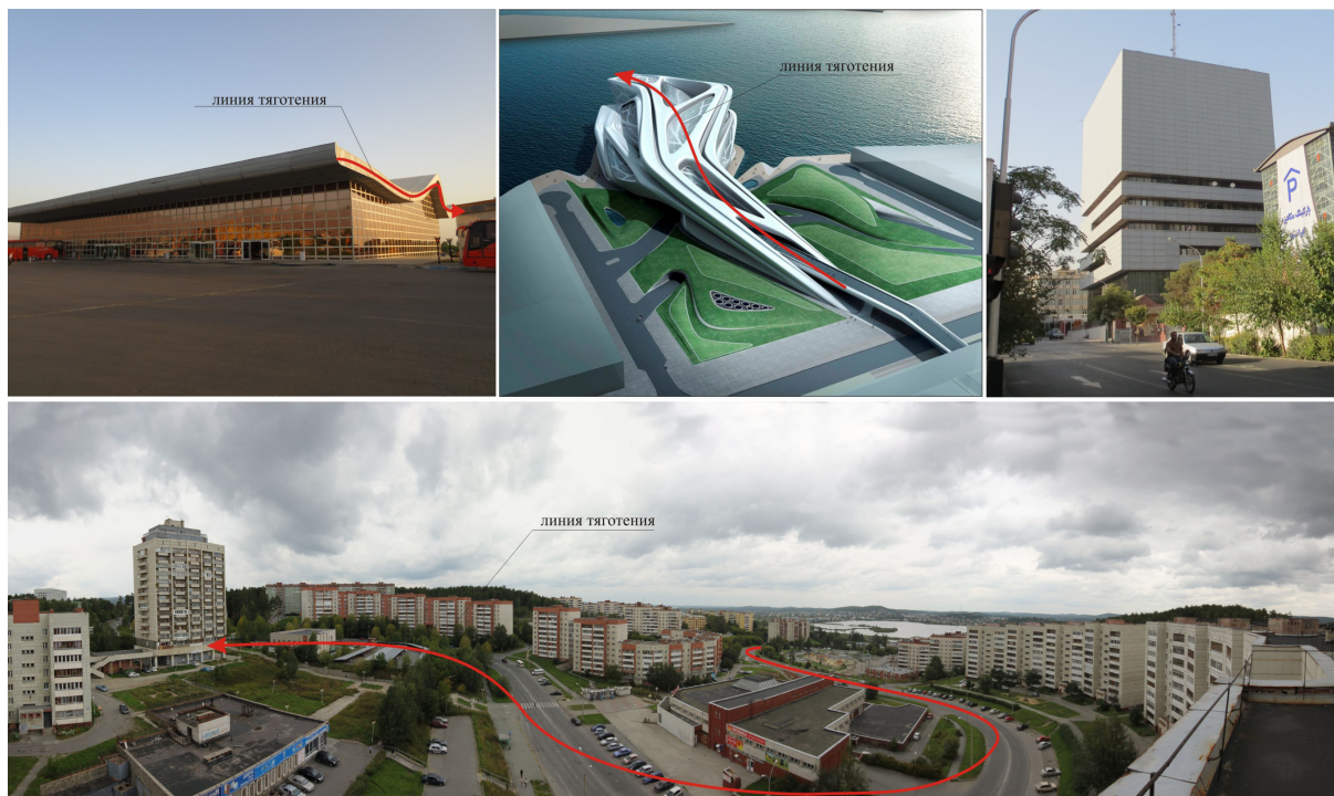
Рис. 2. Слева направо сверху вниз: здание автовокзала в Хамедане в Иране (фото автора); здание Performing Arts Centre в Абу-Даби ( http://stroyka.mk.ua ); здание организации по транспорту и перевозкам в Тегеране (фото автора); общий вид Привокзального района г. Новоуральска (фото автора).
